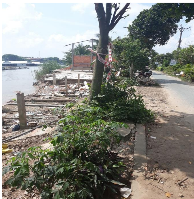
Hình ảnh sạt lở đê bờ Bắc kênh Xáng thuộc xã Tân An năm 2018 – 2022
