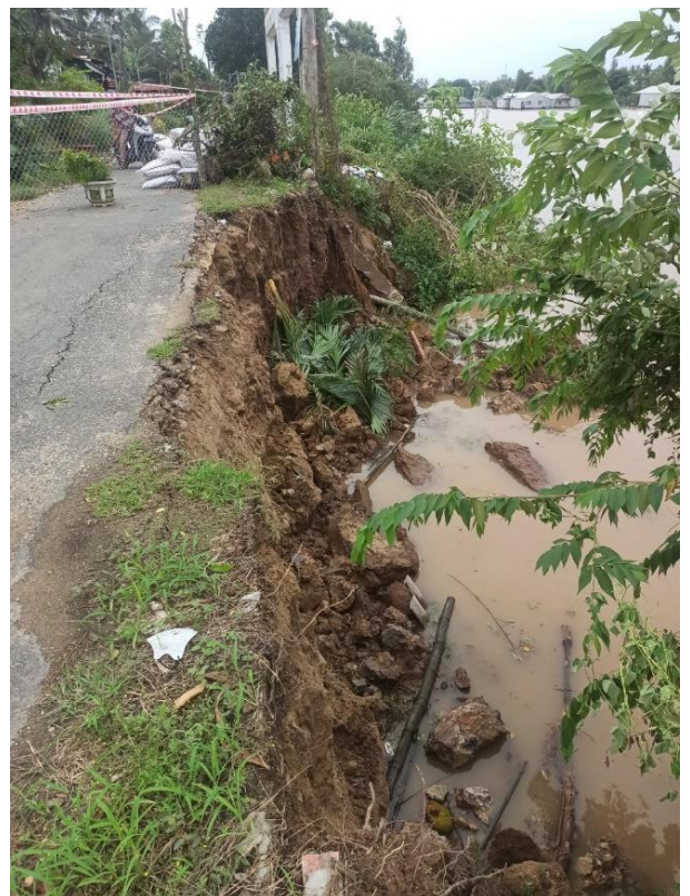
Hình ảnh đoạn từ KM3+000 ÷ KM4+600 sạt lở ngày 19/9/2024, đã được gia cố tạm
