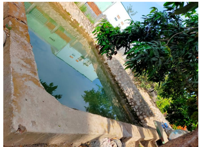
Hình 13. Hồ sơ lắng để chứa nước và bùn thải (Bùn này sẽ thuê đơn vị hút định kỳ 6 tháng/1 lần)
