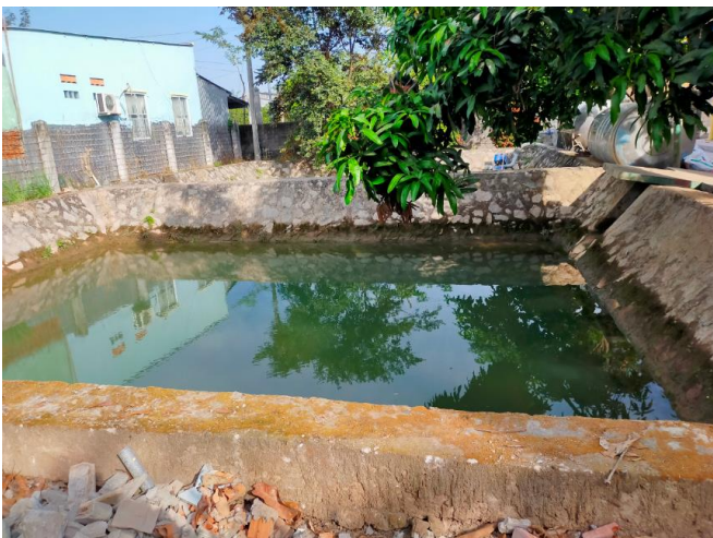
Hình 13. Hồ sơ lắng để chứa nước và bùn thải (Bùn này sẽ thuê đơn vị hút định kỳ 6 tháng/1 lần)
